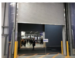
扉の開放による常時換気
